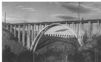
En la foto se puede apreciar el viaducto de los Quince Ojos detrás del puente del Aire. Este viaducto, de 130m de longitud por 35m de anchura, sigue permitiendo a los vehículos hoy en día el cruce del arroyo en la carretera de La Coruña. Los arcos más altos, actualmente semienterrados, tenían unos 30m de altura y un esbelto trazado, desfigurado al haberse habilitado el espacio inferior para almacenes. Obra de Eduardo Torroja de 1933.
