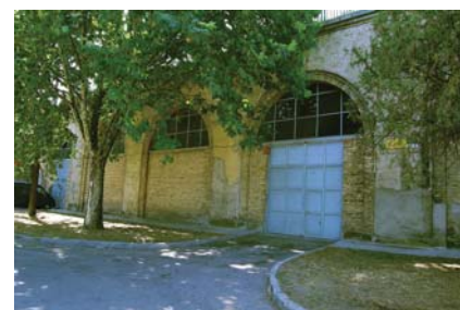
El viaducto de los Quince Ojos de Eduardo Torroja en la actualidad. Sólo quedan libres dos de sus «ojos» para el paso inferior de vehículos, otros tres están ocupados por la UCM, nueve por el Ministerio de Fomento y el último por el Ayuntamiento de Madrid.
