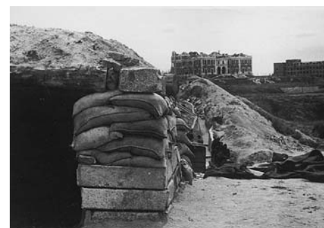
Fortificaciones junto a la actual carretera de La Coruña. Al fondo, la casa de Velázquez.
