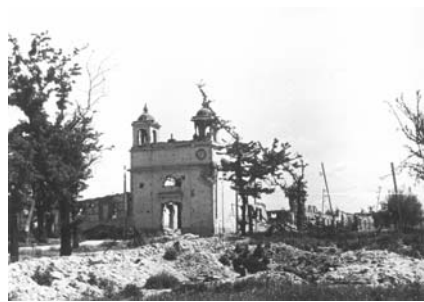
Capilla de San Fernando al final de la guerra civil. Se aprecia su precario estado, lo que obligó a su demolición. Biblioteca Nacional, Guerra Civil, caja 61..
