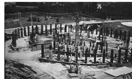
Fotografía tomada durante la construcción en 1967 del Centro de Restauraciones Artísticas –hoy sede del Instituto del Patrimonio Cultural de España–, detrás se observa el Viaducto del Aire, que aún no ha sido enterrado. DVD El Autor enseña su obra, vol.3 Higuera y Miró , Madrid, COAM, ETSAM, 2000.
